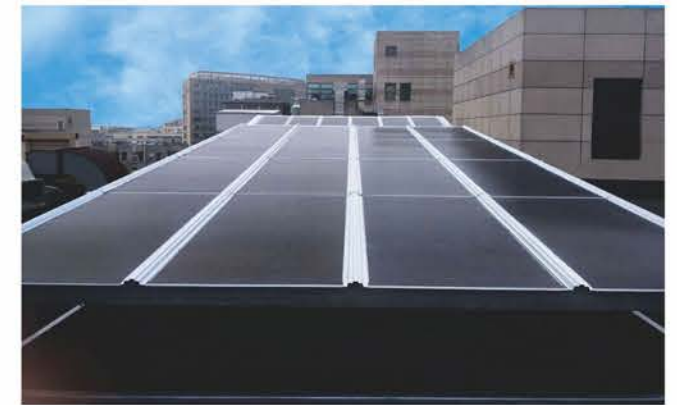
成都龙泉中建集团办公大楼项目
