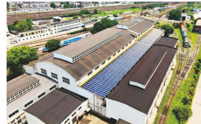
山东淄博高铁机务段火车维护车间项目
