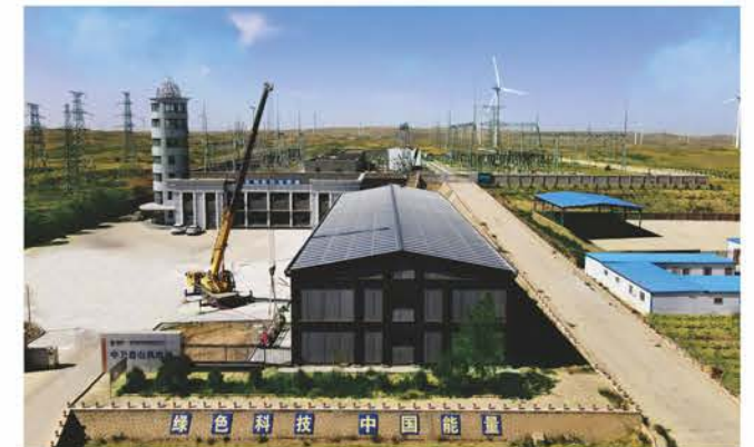
宁夏香山风电场120kw示范项目
